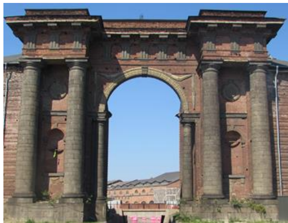
Рисунок 3 - Вид арки Валлен-Деламота с набережной реки Мойка в Санкт-Петербурге
