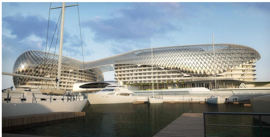
Рисунок 2 - Покрытие из стали и стекла над двумя зданиями гостиницы, Абу-Даби (ОАЭ)
