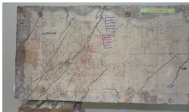
Рисунок 5 – Картина образования и развития трещин при проведении испытаний железобетонных конструкций второй серии на кручение с изгибом
