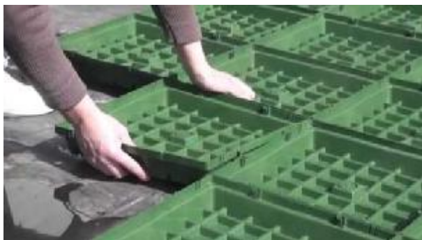
Рисунок 1 – Устройство модульных зеленых кровель
