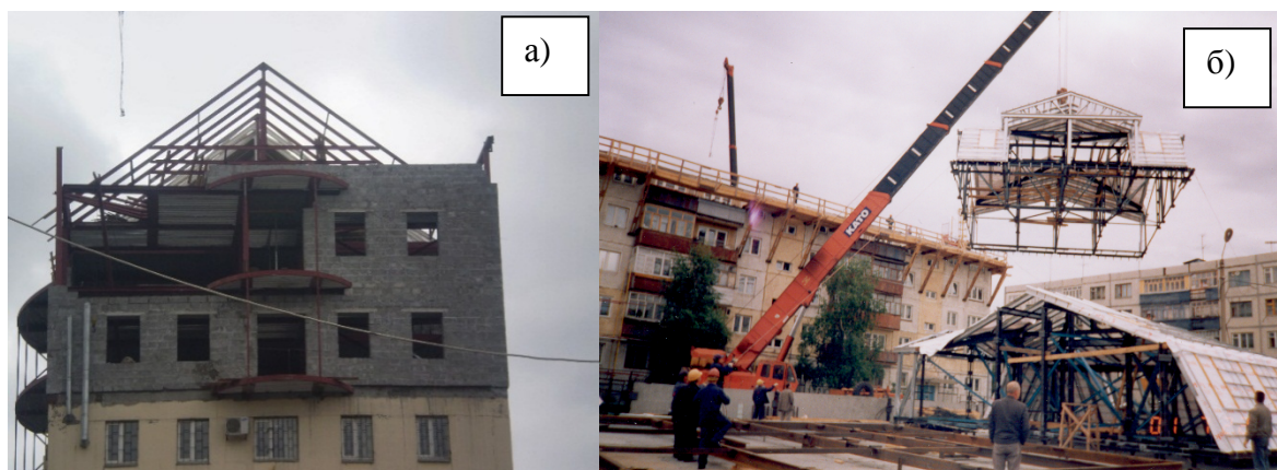
Рисунок 2 – Увеличение полезной площади при надстройке в металлическом каркасе двух полноценных этажей при его поэлементной сборке в г. Днепропетровске (а) и мансардного этажа из предварительно собранных на земле пространственных блоков в г. Сургуте (б)
