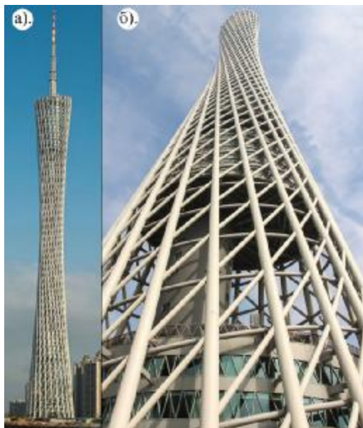
Рисунок 2 – Телебашня «Canton Tower» высотой а – общий вид башни; б – оболочка из трубобетонных элементов
