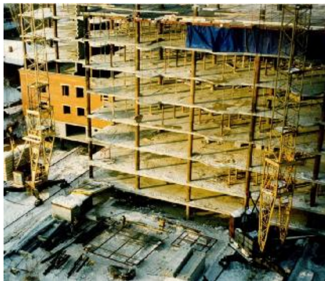
Рисунок 11 – Общий вид 12-и этажного здания с вертикальными несущими конструкциями из трубобетона
