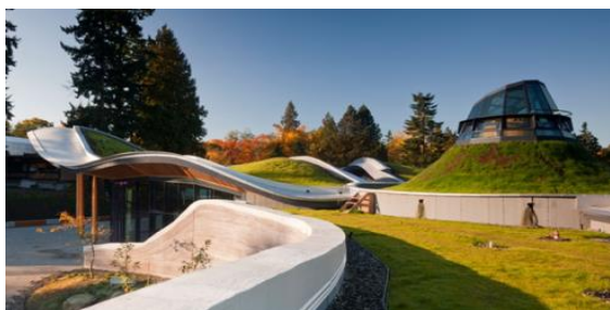
Рисунок 4 - Зеленая кровля Посетительского центра ботанического сада VanDusen, Канада, 2011г. (Источник: https://archi.ru/projects/world/10316/posetitelskii-centr-botanicheskogo-sada-vandusen )
