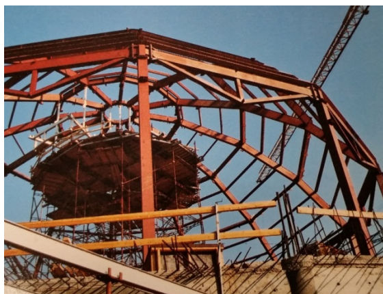
Рисунок 14 - Монтаж трубчатых металлических дискретных арок покрытия купола на колонны и верхнее опорное кольцо (Источник: материалы цирка Никулина на Цветном бульваре)
