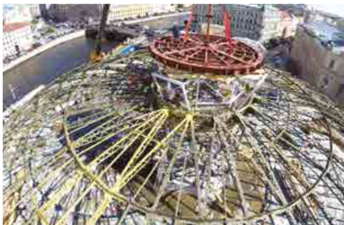
Рисунок 7 – Монтаж нового дублирующего несущего купола Санкт-Петербургского цирка, 2015 г. Источник: [8]
