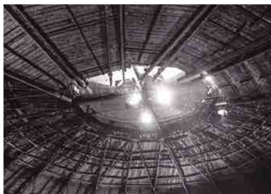
Рисунок 6 – Демонтаж деревянного настила купола Ленинградского цирка (1963 г.) Источник: [8]
