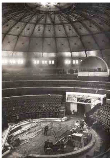
Рисунок 5 – Реконструкция Ленинградского цирка (1927 г.). Источник: [8]
