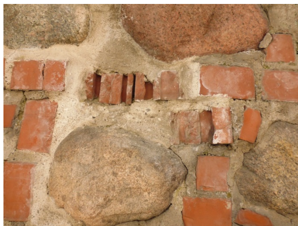
Рисунок 3 – Фрагменты реставрированной стены
