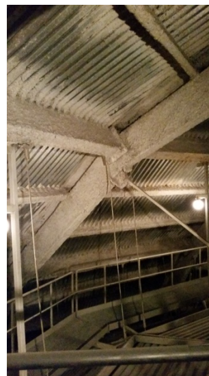
Рисунок 13 – Трубы прямоугольного сечения несущей системы покрытия цирка на Цветном бульваре (Источник: фото авторов)
