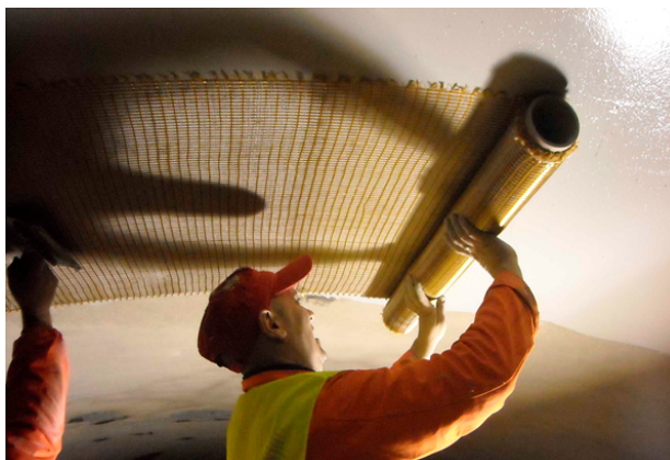
Рисунок 3 – Усиление каменных сводов сетками из композитных материалов с наружной (а) и внутренней (б) поверхностей
