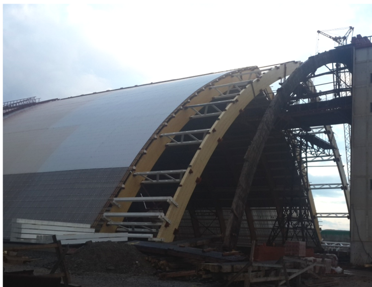
Рисунок 1 - Стрельчатый склад пролетом 45 метров
