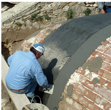
Рисунок 3 – Усиление каменных сводов сетками из композитных материалов с наружной (а) и внутренней (б) поверхностей
