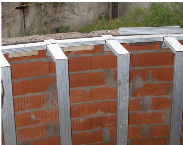
Рисунок 1 - Конструктивное решение ограждающих конструкций с устройством наружного слоя стены из керамического кирпича (а), внутреннего слоя из гипсокартона с заполнением среднего слоя теплоизоляционным пенобетоном (б)
