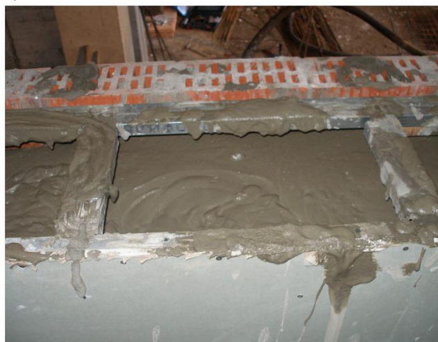
Рисунок 1 - Конструктивное решение ограждающих конструкций с устройством наружного слоя стены из керамического кирпича (а), внутреннего слоя из гипсокартона с заполнением среднего слоя теплоизоляционным пенобетоном (б)
