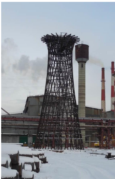
Рисунок 3 – Водонапорная башня Выксунского металлургического завода. Общий вид. 2018 г.
