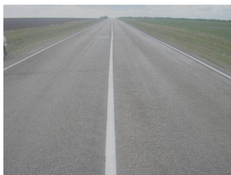
Рисунок 3 – Общий вид отремонтированного участка после нанесения дорожной разметки
