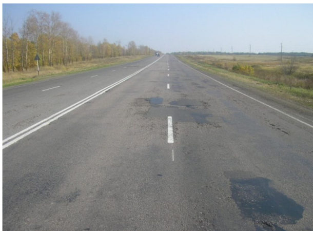
Рисунок 1 – Фото участка автомобильной дороги федерального значения после ремонта горячей асфальтобетонной смесью
