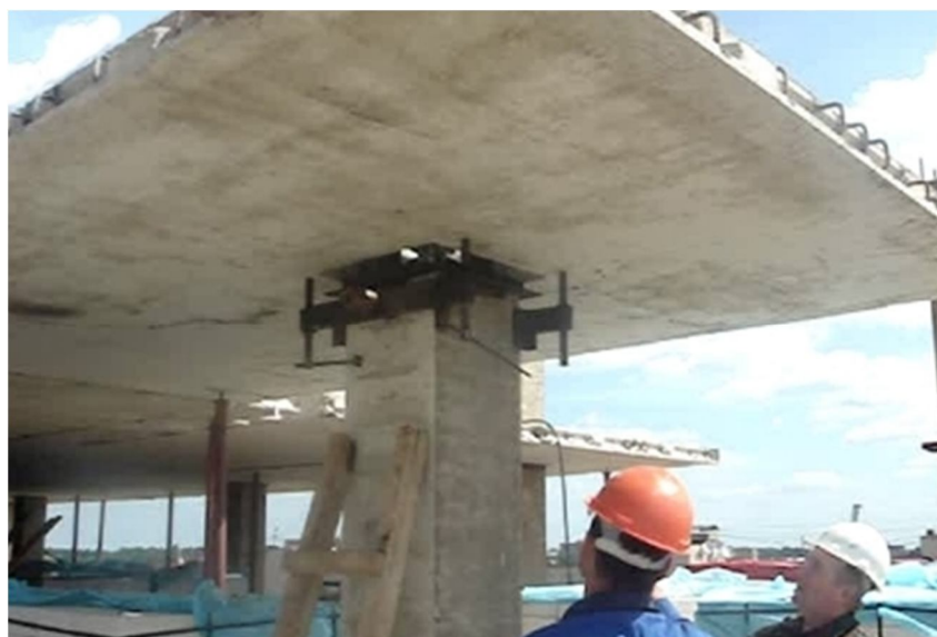
Рисунок 5 – Принудительный монтаж надколонной плиты с использованием кондуктора и опорного столика
