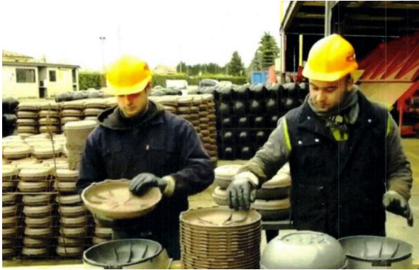
Рисунок 4 – Сборка вкладышей на строительной площадке
