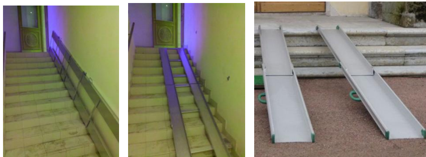
Рисунок 2 – Откидной и складной пандусы
