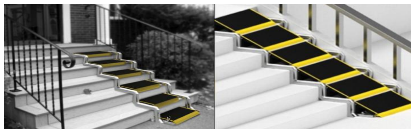
Рисунок 3 – Складывающийся пандус для узких лестниц
