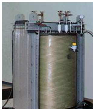
Рис 3. ВТСП-трансформатор мощностью 500 кВА
