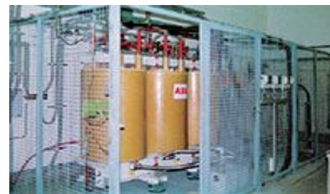
Рис. 1. ВТСП-трансформатор мощностью 630 кВА.
